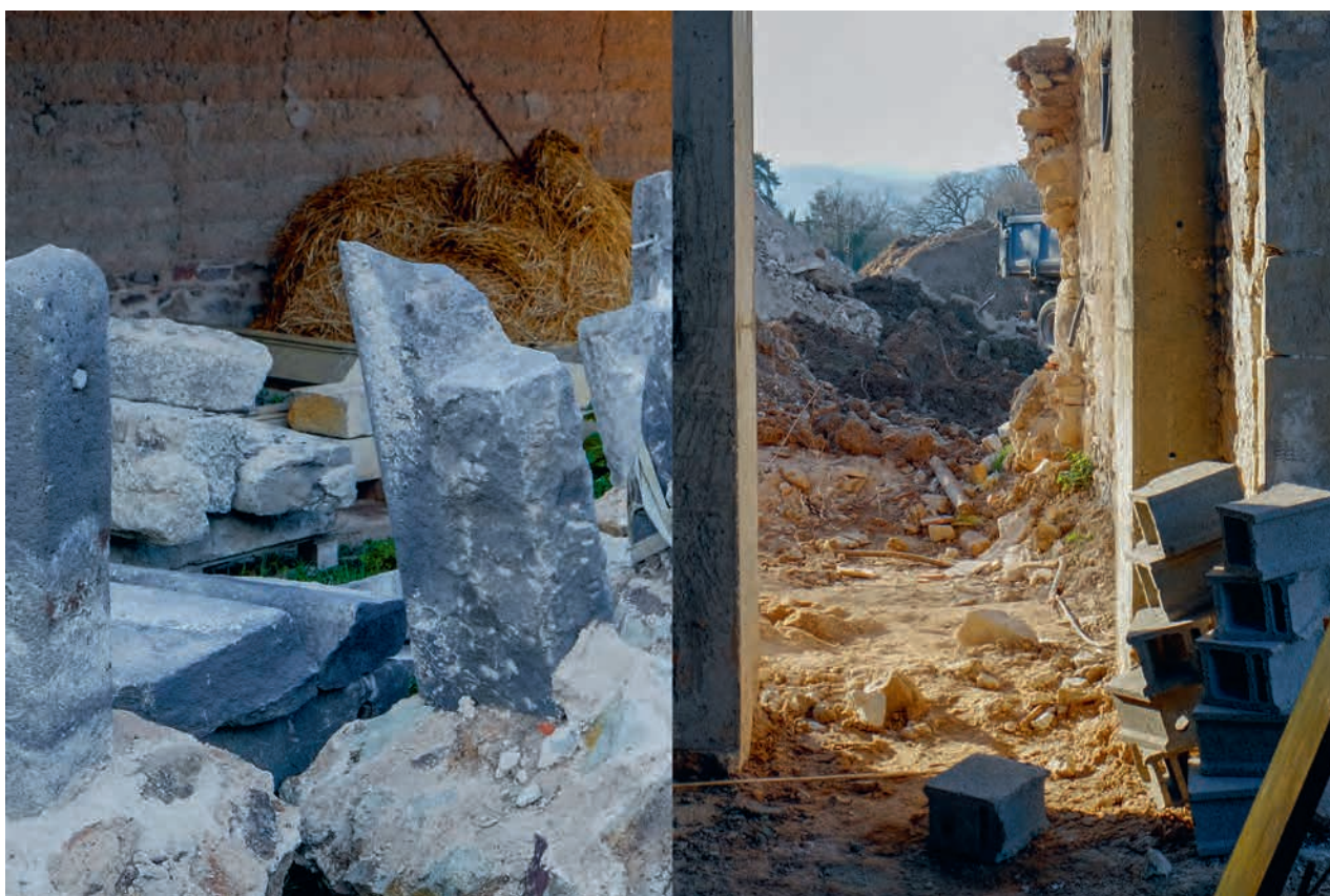
Diptyques d'un carnet pour Michel et Marie-Pierre Troisgros • Chantier à Ouches
